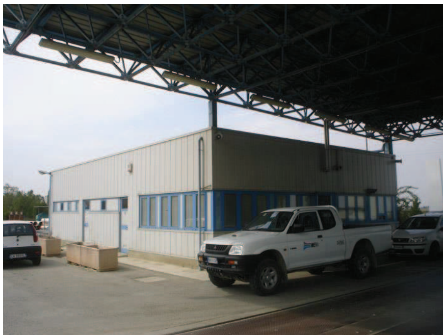
Fabbricato uffici – Fronte Nord – lato discarica
