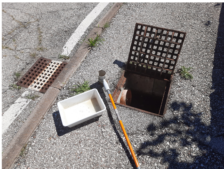
Fig. 03– Controllo di qualità su una caditoia stradale
