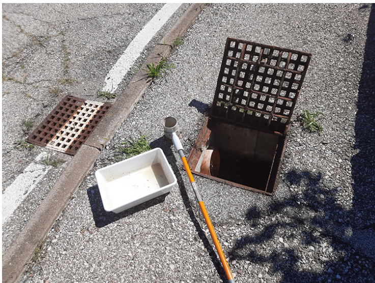
Fig. 03– Controllo di qualità su una caditoia stradale
